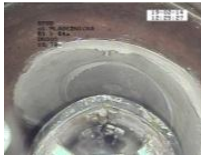
typ „C“ OPRAVA – LOKÁLNÍ UTĚSNĚNÍ SPOJE „ŠACHTA-POTRUBÍ“
