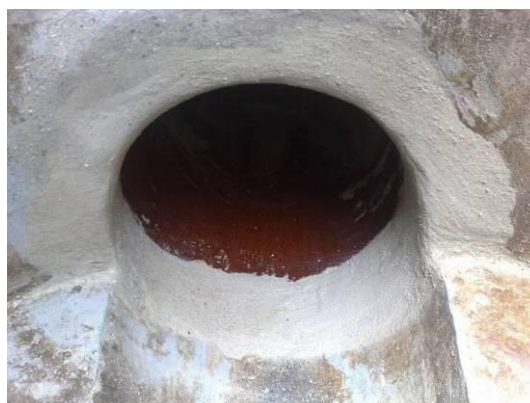
typ „D“ RENOVACE – KANALIZAČNÍ ŠACHTY hl. cca 3,5m
