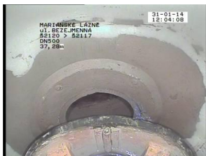
typ „C“ OPRAVA – LOKÁLNÍ UTĚSNĚNÍ SPOJE „ŠACHTA-POTRUBÍ“
